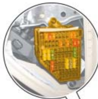
Sicherungshalter, Schalttafel rechts
