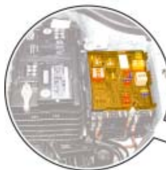
Sicherungs- und Relaisbox, Motorraum links
